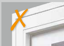
Teiste tootjate välisuste sisekülg nähtava raamkonstruktsiooni ja klaasiliistudega
